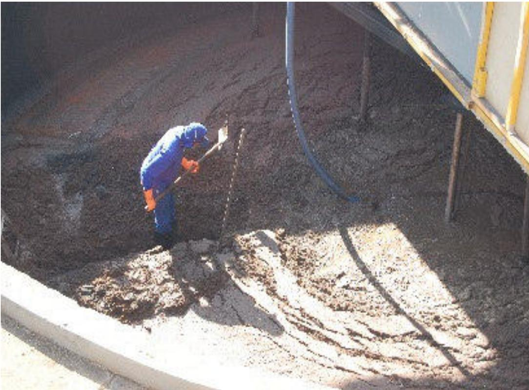
**ETE Sul – Limpeza do desarenador após receber grande quantidade de sedimentos.**
