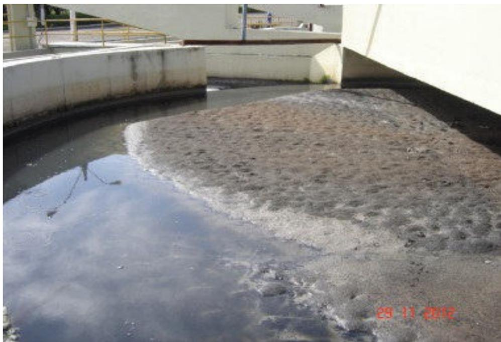
**ETE Samambaia – Desarenador em manutenção para retirada de areia. 100% comprometido**
