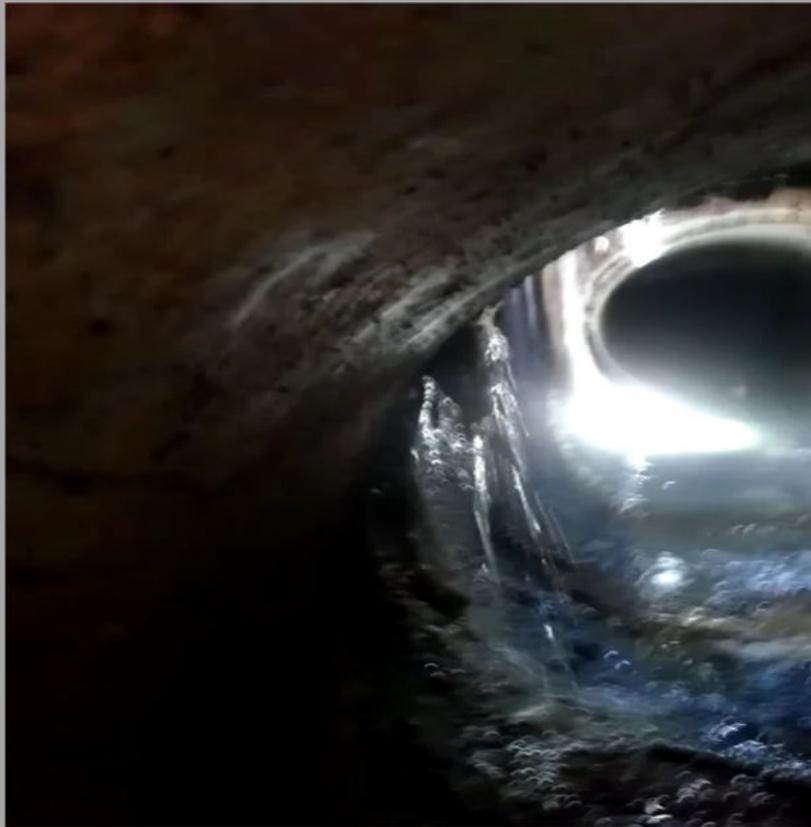
**ÁGUA PLUVIAL EM REDE DE ESGOTO**
